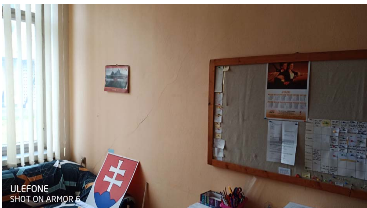
Trhliny v stene kancelárie vychádzajú diagonálne od základov čo signalizuje ich posuny.
