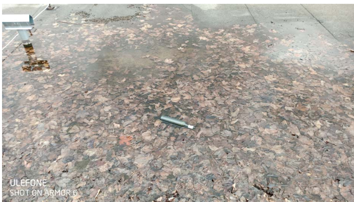
Vodná kaluž nad prehnutým panelom vodný stĺpec reprezentuje zatopená fľaša.
