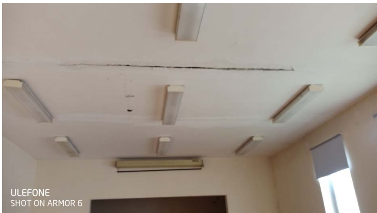
Deformovaný panel s priehybom 50mm
