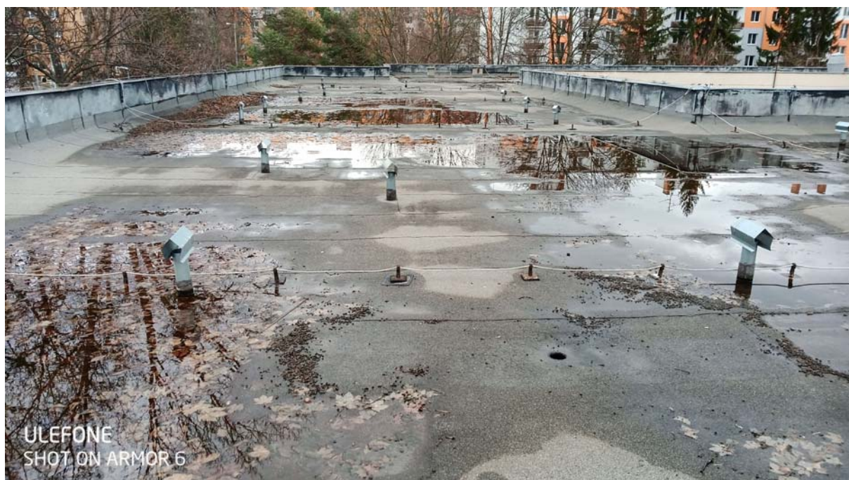
Strecha objektu zo stojacou vodou.
