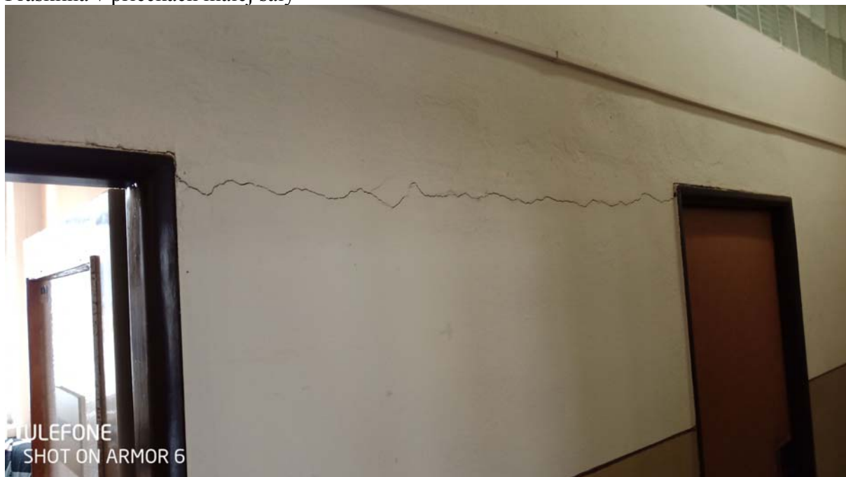
Trhlina v stene na chodbe.
